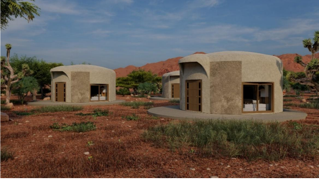
Şekil 13. Özel Betonlarla tasarlanan hızlı deprem konutu
