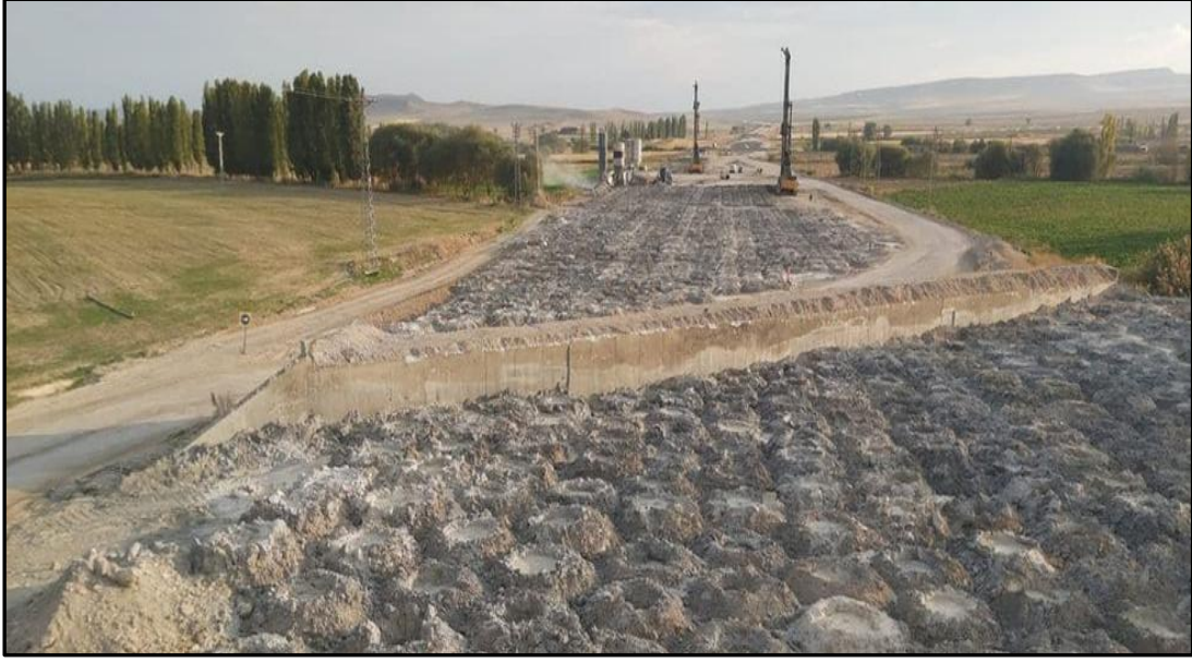
Şekil 5. DSM uygulaması yapılmış inceleme alanı genel görünümü
