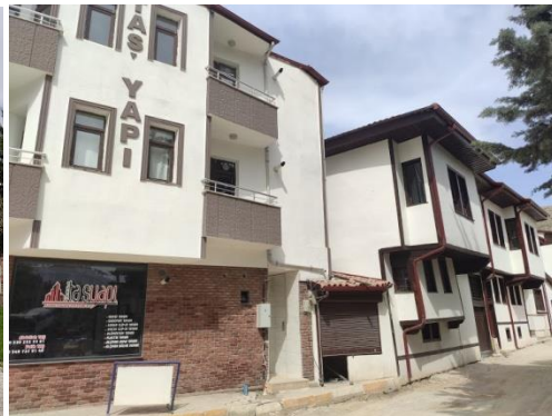
Fotoğraf-3: Modern Yapı ile Tarihi Yapı
