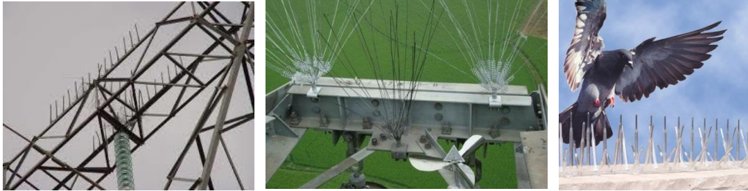
Şekil 1. Metal ve metal olmayan malzemeden yapılmış diken biçiminde kuşkonmazlar
