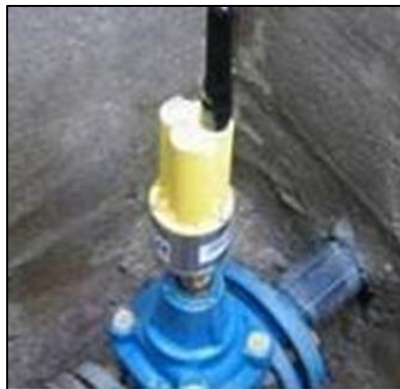
Şekil 7. Sinyal İle Çalışan Permalog Sistemi
