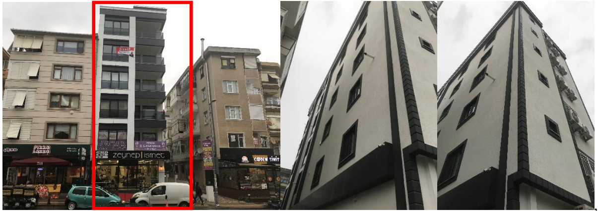
Şekil 5. Yapı fotoğrafları (Güney, Doğu ve Kuzeydoğu cepheleri)
